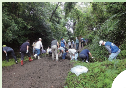
6月 「かっぱ恵みの森」 側溝の土砂あげ作業
