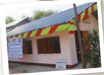
▲給食室の改装後
